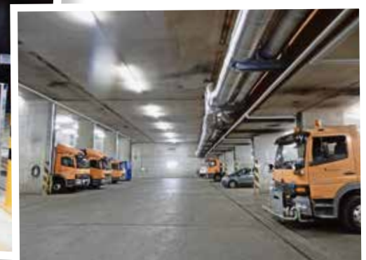
In der grossen Garage stehen alle Wagen, die gerade nicht gebraucht werden.
